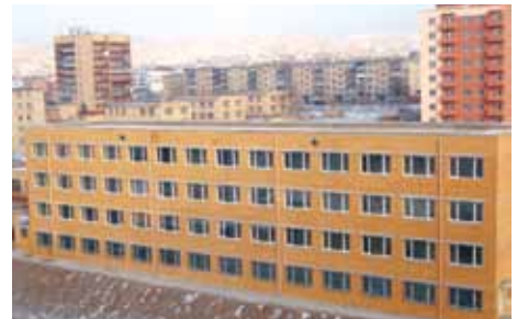
初等教育施設整備計画によって 建設された校舎（ウランバートル）
