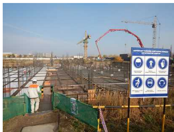
基礎工事の様子(2016年9月24日撮影)
