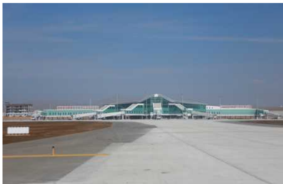
工事中のターミナルビル(2016年9月24日撮影)
